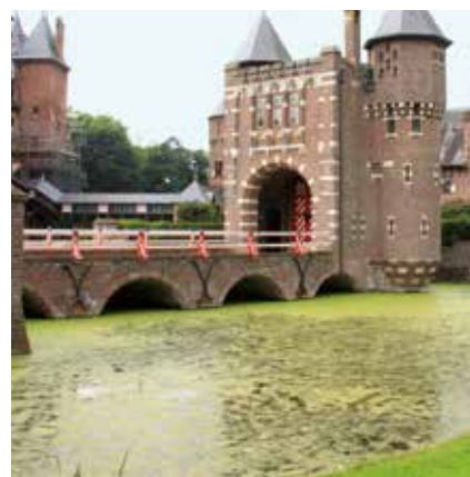
Stankoverlast door zuurstofgebrek.
